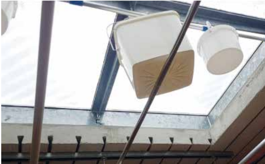
Eimer fangen Kondenswasser auf
