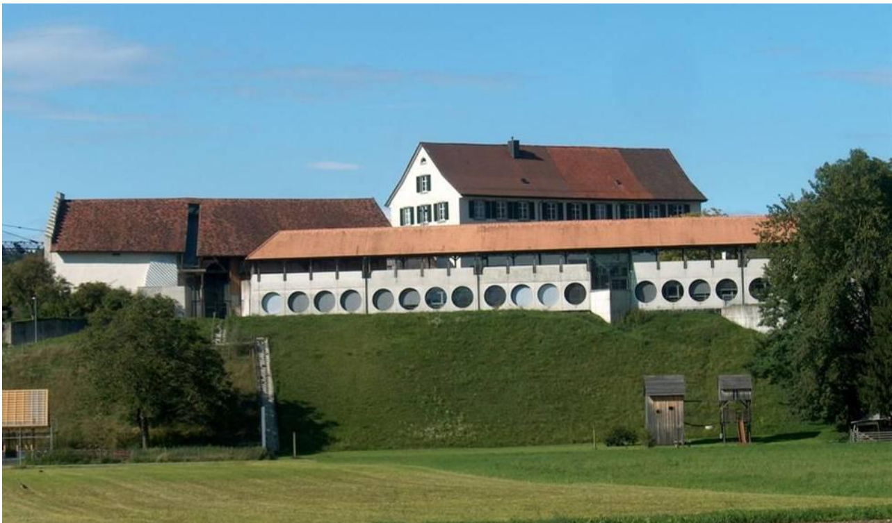
Schulanlage von Süden mit Trotte, Schulhaus Kastell und Schulhaus Schloss im Hintergrund
