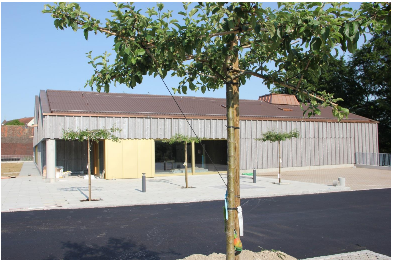
Der fast fertige Haupteingang der Mehrzweckhalle an der Berglistrasse 28
