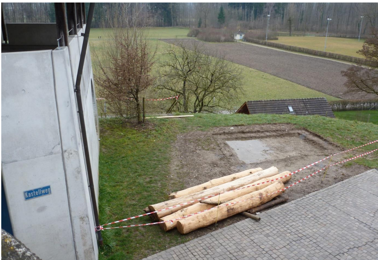
Das Holz für die Umrandung des neuen Sandkastens liegt bereit
