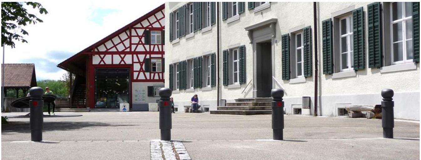
Die Absperrpfosten sind montiert, die Kirchgemeinden mit einem Schlüssel bedient.
